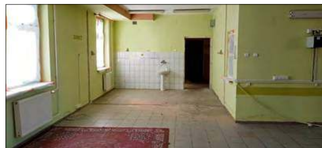
Prace przy budowie kuchni już ruszyły.
