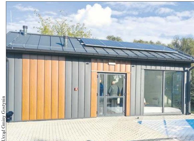
Nowo wybudowana świetlica wiejska w Belnie
