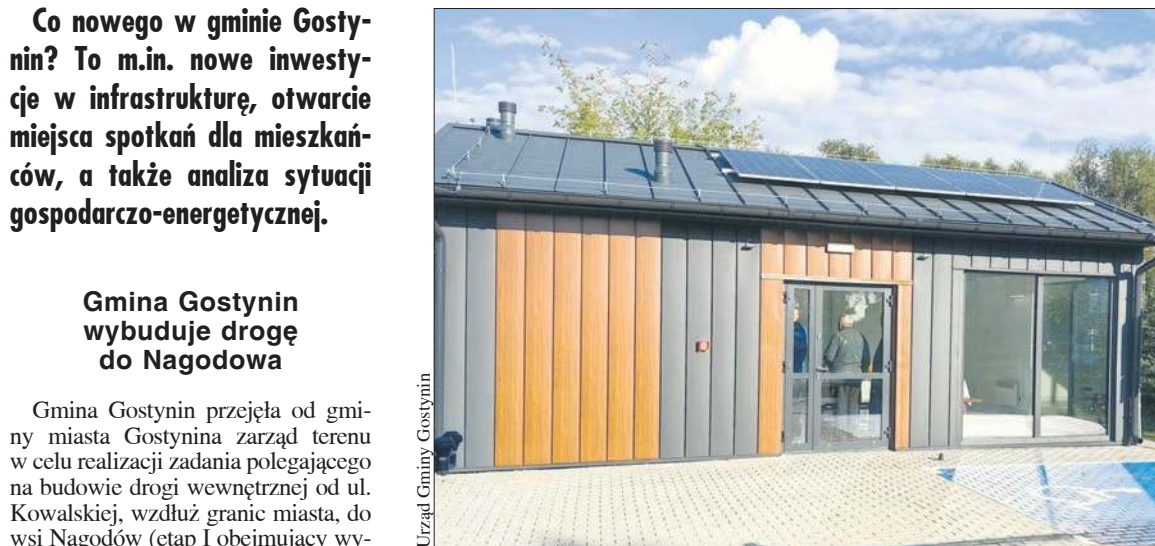
Nowo wybudowana świetlica wiejska w Belnie
