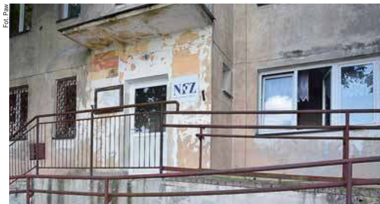
Budynek gdzie znajdował się będzie ośrodek zdrowia
