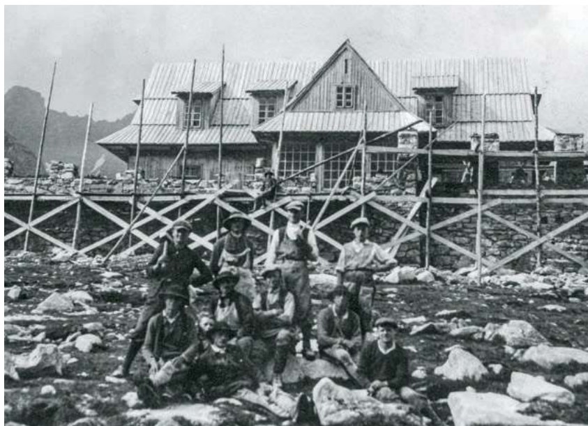
Ekipa budowniczych okładająca kamieniem stare schronisko według projektu Karola Stryjeńskiego, 1933 r.
