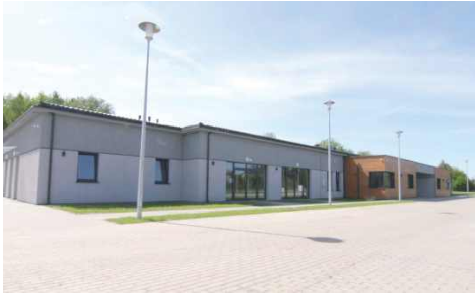
Nowy budynek żłobka i przedszkola w Terespolu
