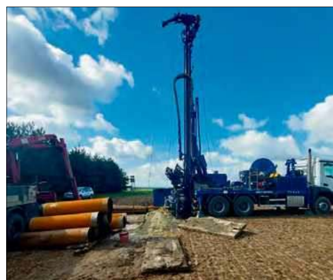
W Dziezicach wykonano odwiert studzienny pod budowę Stacji Uzdatniania Wody.
