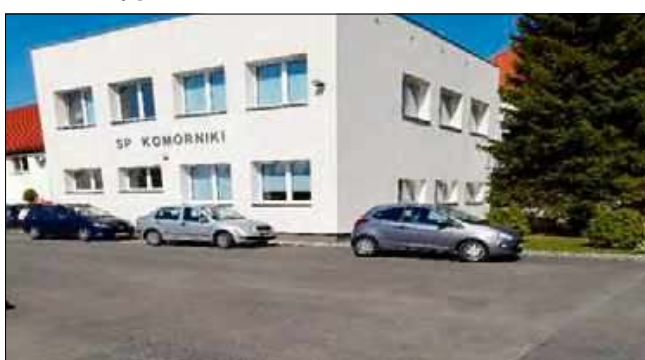
Parking przed Szkołą Podstawową w Komornikach też został wyremontowany. Koszt inwestycji wyniósł nieco ponad 90 tysięcy złotych.
