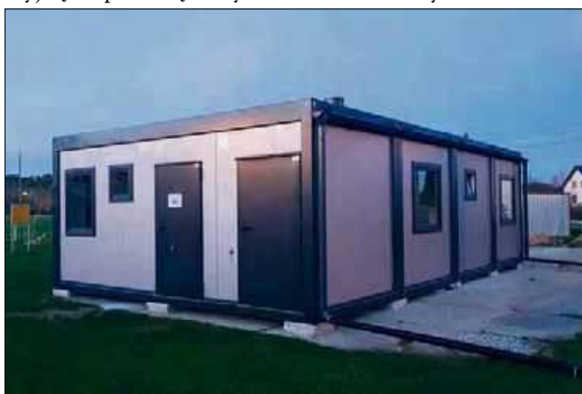
W Dobrej powstała szatnia kontenerowa.
