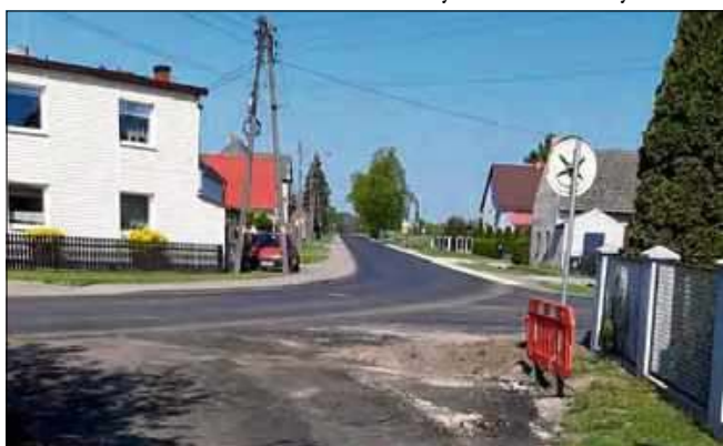
Rozbudowano także sieć wodno-kanalizacyjną w dwóch miejscowościach.
