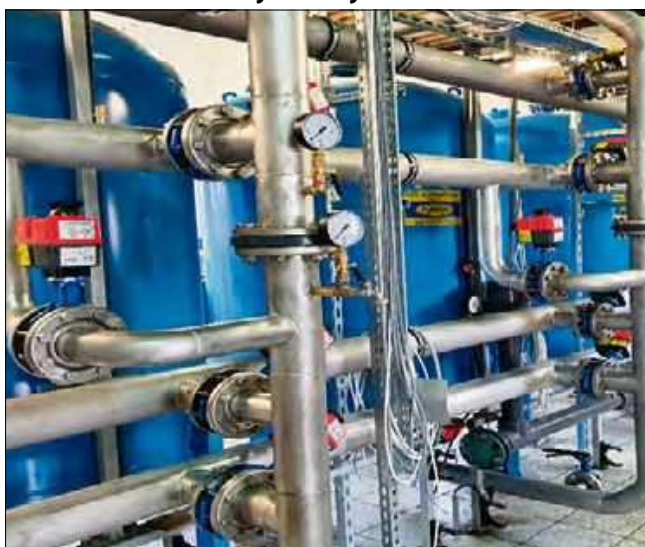
Sporo zainwestowano w modernizację Stacji Uzdatniania Wody w Nowym Budzie.
