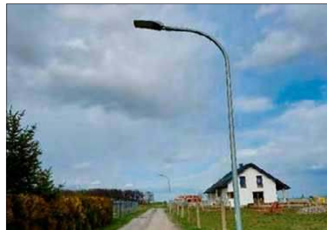
W 2022 roku zamontowano 6 lamp na ulicy Sportowej w Dobrej. Całkowity koszt zadania wyniósł 36 902,56 zł.
