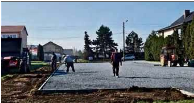
Budowa parkingu rozwiąże problem braku miejsc parkingowych koło cmentarza w Straduni.
