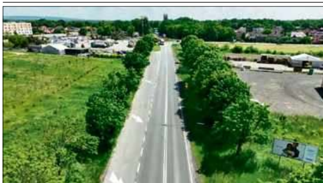
Przebudowa DK45 odbywa się na odcinku niespełna 7 kilometrów.
