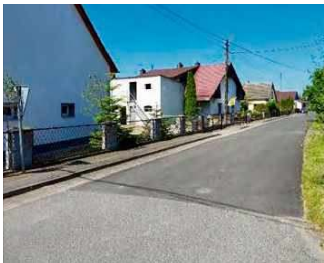
Remont ulic Główniej i Polnej w Dziezicach.
