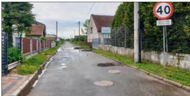
Remont ulicy Wschodniej w Zdzeszowicach zbliża się wielkimi krokami.
