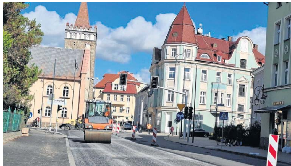
Zmiana organizacji ruchu umożliwi wykonawcy położenie nowego asfaltu.
