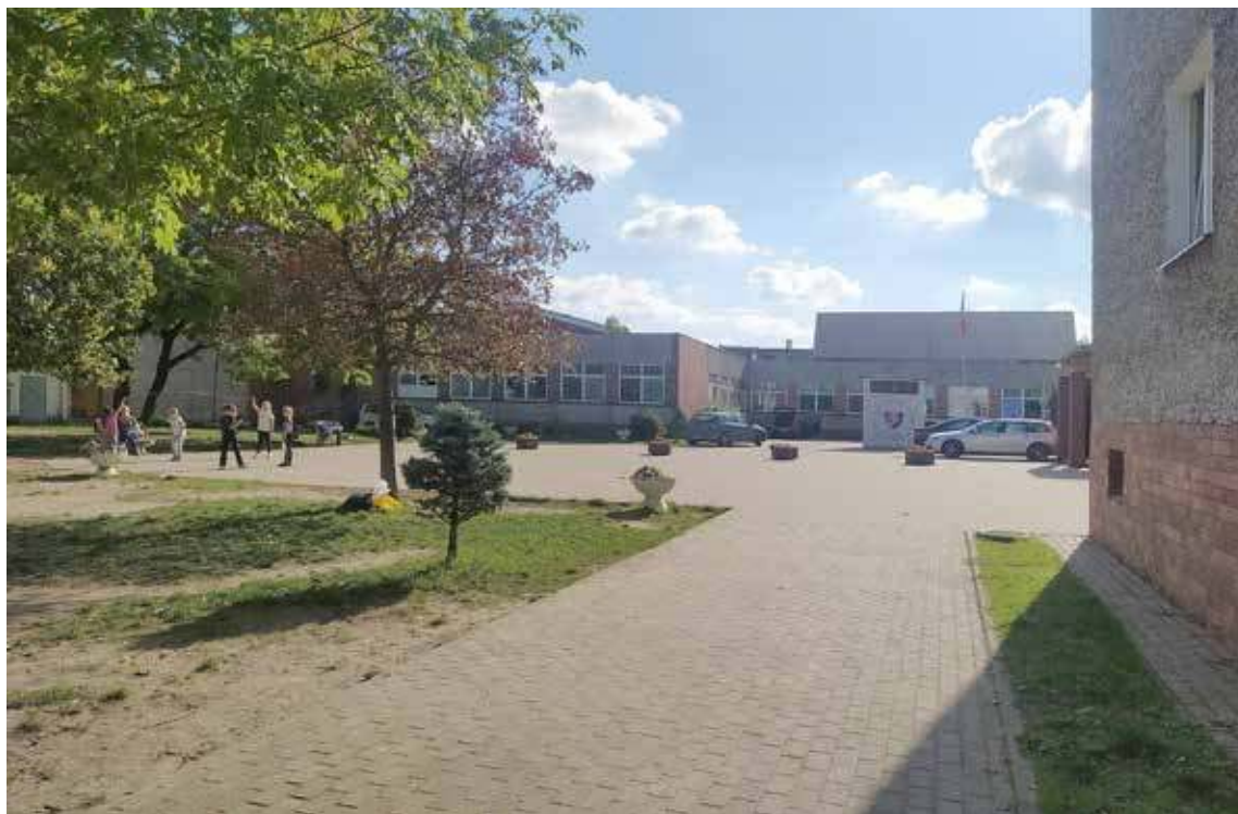
Prace będą widoczne w budynku SP nr 3 i II LO w Nowogardzie
