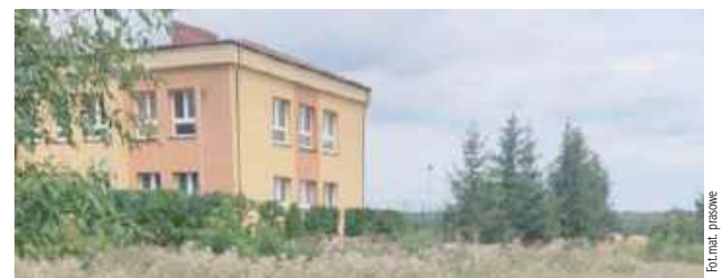
Przy budynku szkoły powstanie wreszcie parking
