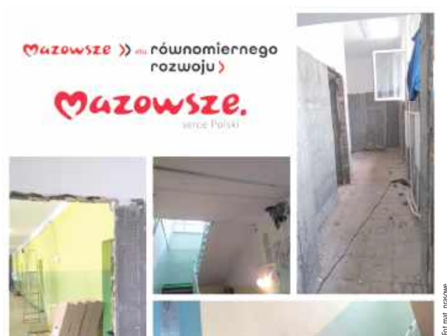
Budynek szkoły w budowie
