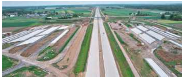
W tym roku ma zostać zakończona budowa odcinków A2 z Warszawy do Białej Podlaskiej
