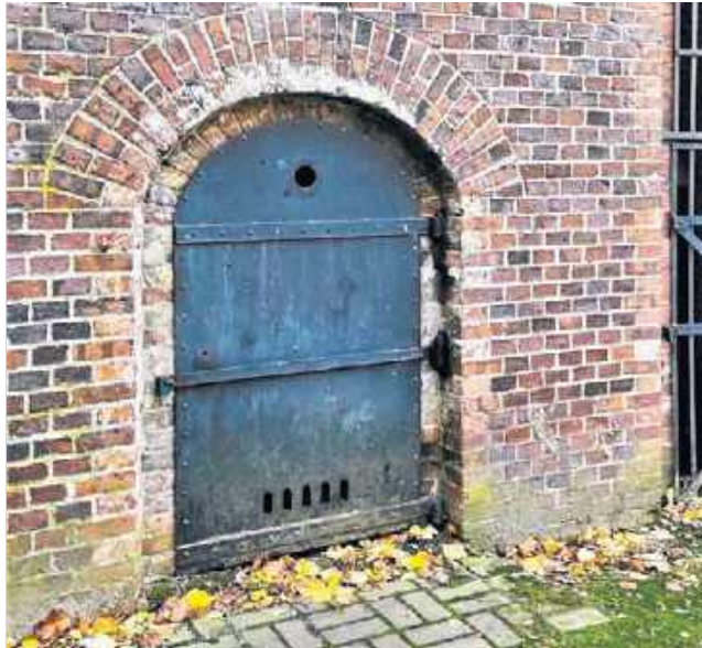
Wejście do tunelu w fosie - tak wygląda obecnie. Wstępu bronią solidne drzwi
