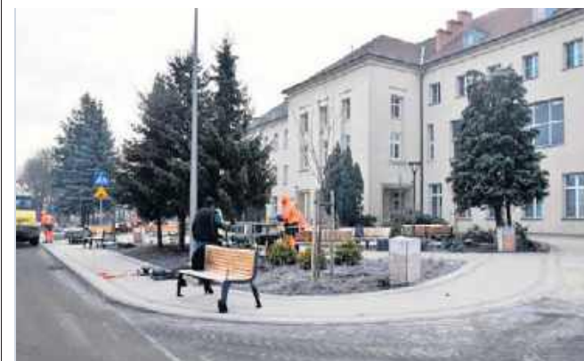
Dopinane są ostatnie prace przed odbiorem, który może nastąpić jeszcze przed Nowym Rokiem
