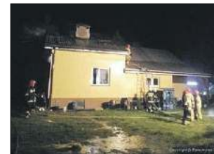
Prawdopodobną przyczyną pożaru było zwarcie instalacji elektrycznej
