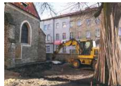
Za prace przy rotundzie św. Gotarda odpowiada firma Globistic z Pęcza. Fot. UMiG Strzelin
