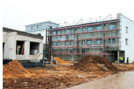
Przebudowany budynek starego oddziału zakaźnego
