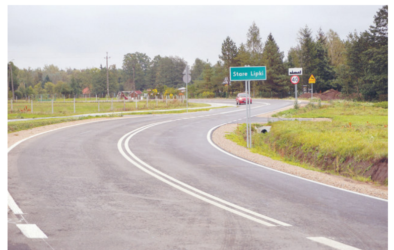
Przebudowana droga powiatowa Stoczek-Stare Lipki
