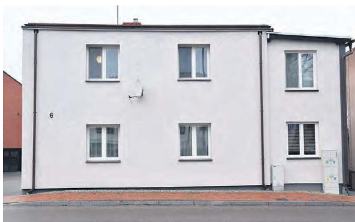
Budynek przy ul. Zamkowej 6.
