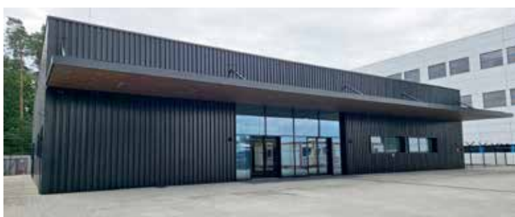
Budynek jest już gotowy
