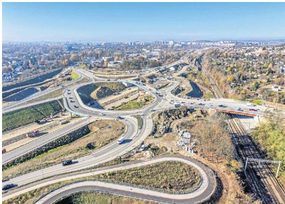
Nowy odcinek S7 otwarty. To kolejne kilometry IV obwodnicy Krakowa
