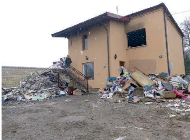
Po pożarze nic nie nadaje się do użytku. Wszystko trzeba było wyrzucić. Czego nie strawił ogień zostało zalane wodą w czasie akcji gaśniczej
