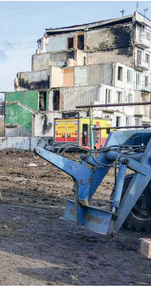
Plac zabaw na osiedlu mieszkaniowym zniszczonym przez ostrzał raketowy. Połtawa, Ukraina, luty 2025 r.
