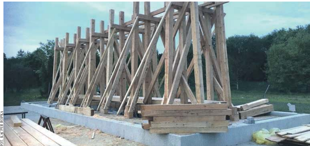
Trwa budowa tężni w Krzeszowicach
