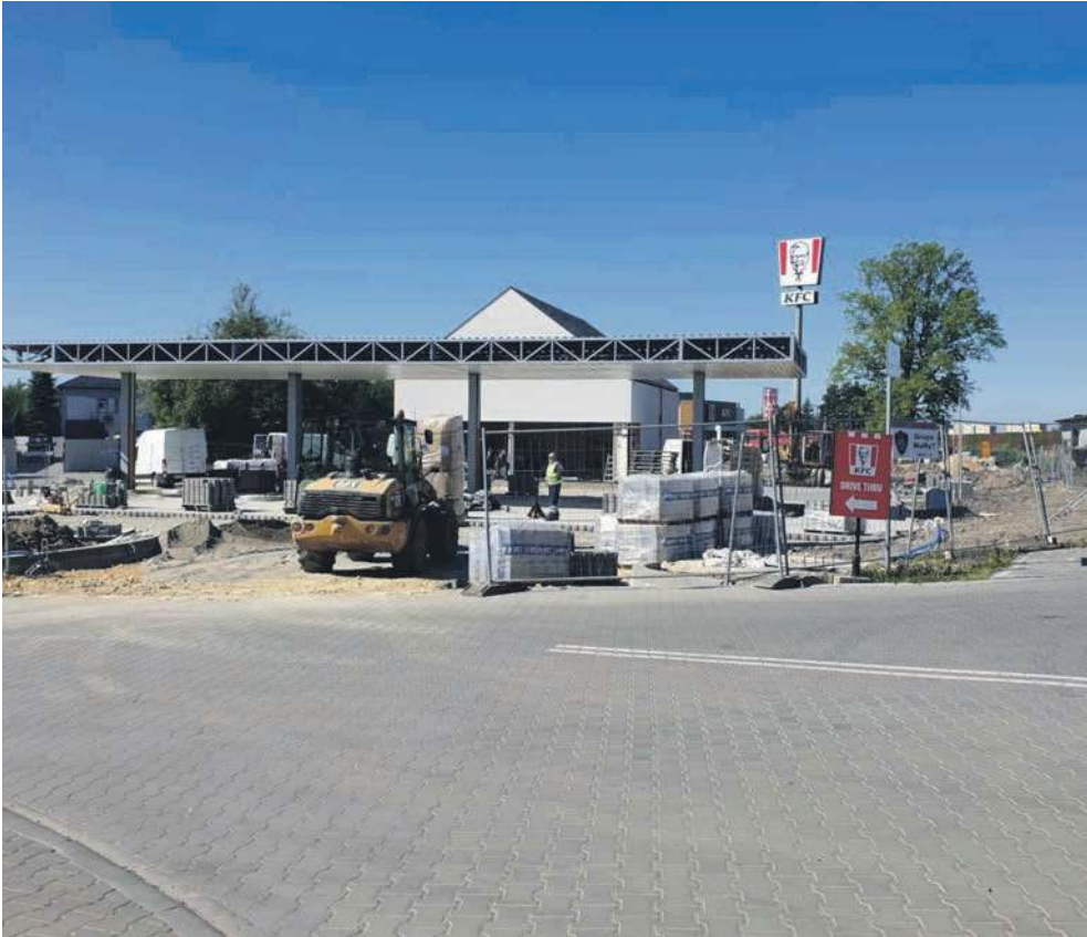
Z ul. Długiej w Trzebini można obserwować budowę nowej stacji paliw
