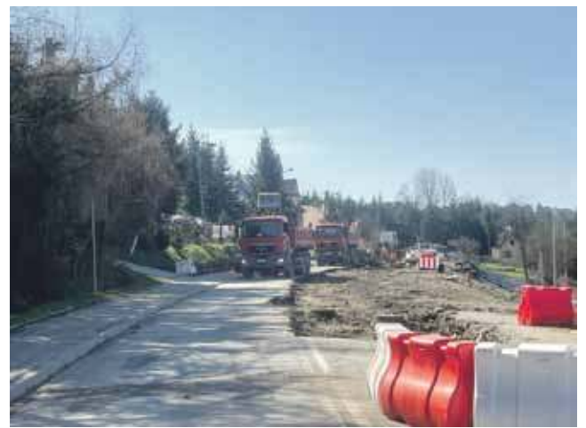
Remont osuwiska w ciągu ulicy Zakopiańskiej.
