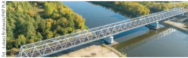
Nad Narwią wybudowany został nowy 245-metrowy most kolejowy
