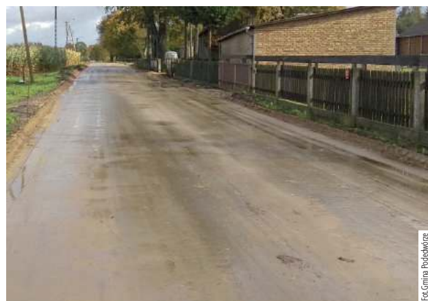
Droga w Piechach dostanie nową nawierzchnię. Utwardzone zostaną zjazdy
