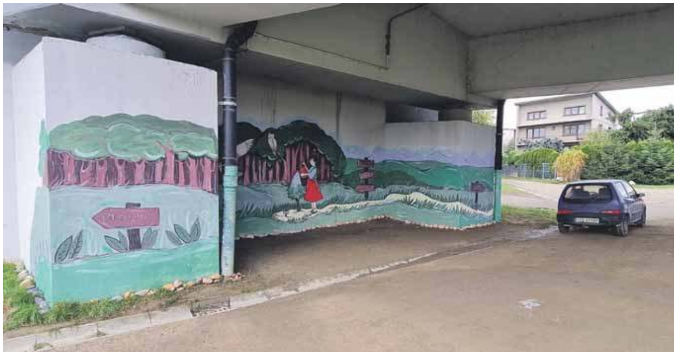
Jeszcze niedawno pod mostem przy ul. Legionów Piłsudskiego było brudno, a ścianę zdobiły bazgroły i brzydkie napisy. Teraz jest tak.
