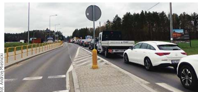
Żeby przejechać koło budowy ronda, trzeba odstać swoje w korku
