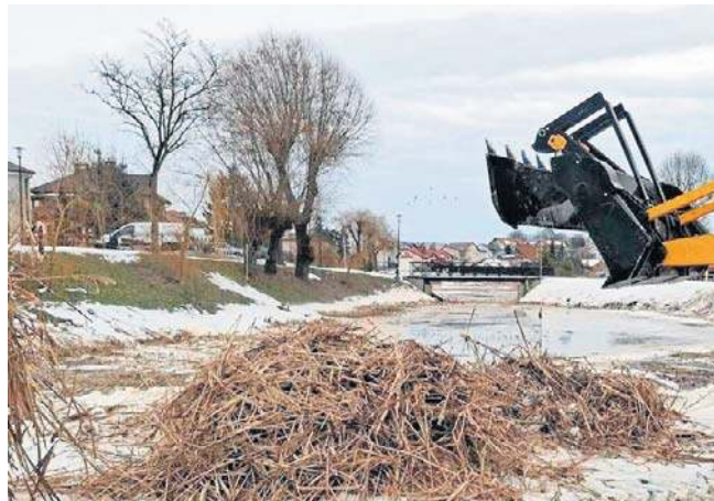
Brzegi stawu i sam zbiornik oczyszczono z uschniętej roślinności
