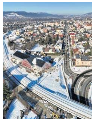
Nowe centrum sterowania kolei na finiszu budowy
