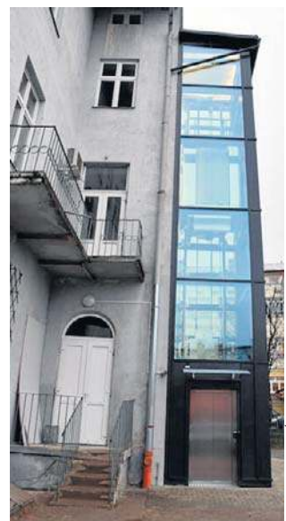
W budynku Urzędu Miejskiego przy ul. Wodnej 11 powstała zewnętrzna widna
