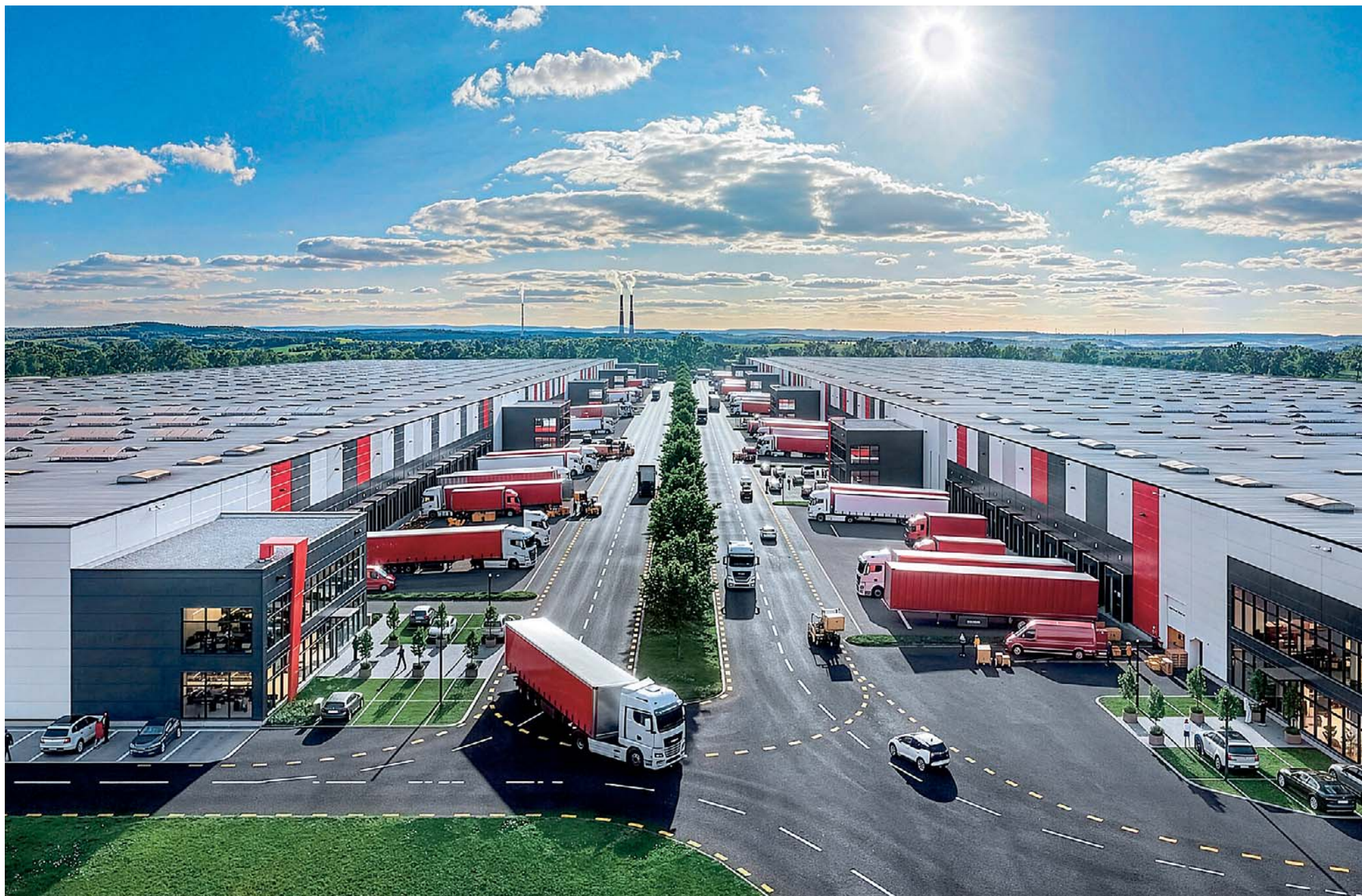
Powstający w Nowej Hucie 7R Hub docelowo osiągnie około 230 tys. mkw. funkcjonalnej powierzchni techniczno-produkcyjnej w nowoczesnym standardzie
