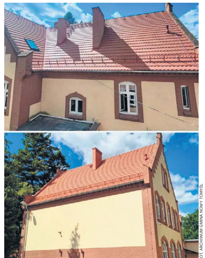
Odnowiony dach Zespołu Szkolno-Przedszkolnego w Bukowcu po zakończeniu prac
