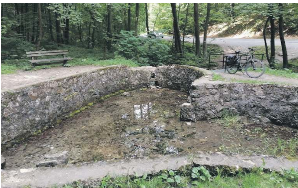
Źródło Miłości zostało ujęte w oryginalną, kamiennieo-betonową obudowę w kształcie serca
