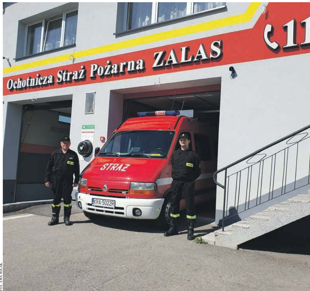
Strażacy OSP Zalas przy wyremontowanej remizie
