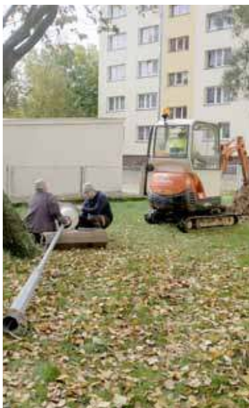
Prace przeprowadzono w czwartek, 17 października
