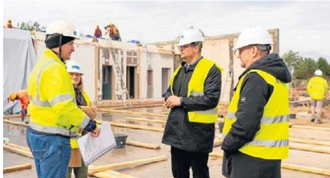
Trwa montaż „modułowego” żłobka
