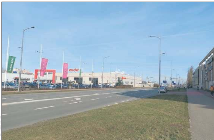
Rozpoczął się remont ulicy Przemysłowej. Prace na odcinku pomiędzy ul. Tysiąclecia i NSZ potrwać trzy miesiące
