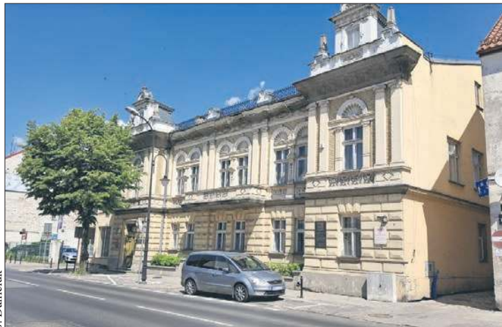
Po przeprowadzce USC do nowego obiektu wyremontowana zostanie reprezentacyjna, zabytkowa część urzędu
