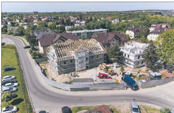
Trwa budowa dwóch ostatnich bloków na osiedlu Miodowa Jar
