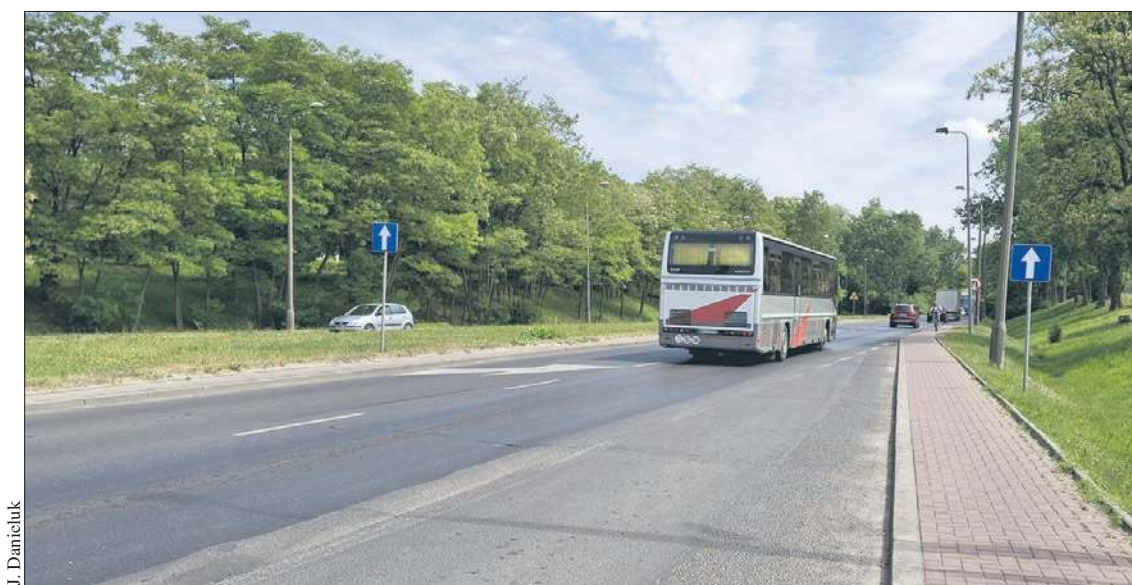
Urząd Miasta Płocka Miasto odpowiada za rozbudowę ulicy Wyszogrodzkiej pomiędzy Podolszyczami a ul. Harcerską
