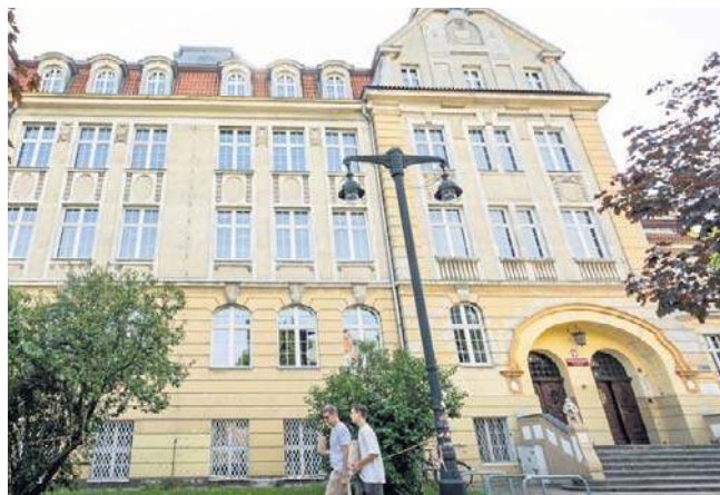
Budynek VI LO powstał w latach 1908 – 1910 z inicjatywy Rady Miejskiej w Bydgoszczy
