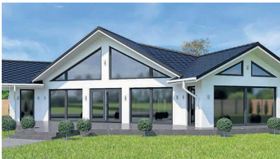
Dom hybrydowy firma Maj-Haus z Rzepina opracowała w oparciu najnowsze na rynku rozwiązania. To budynek ekologiczny, do jego budowy wykorzystuje się jak najwięcej materiałów naturalnych
