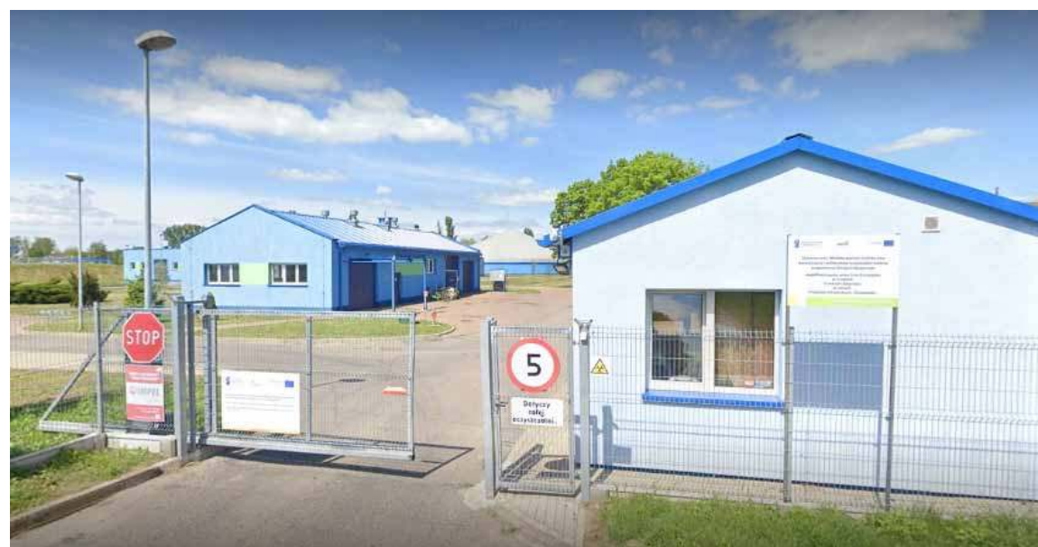
Z PŁ dla miasta - 20 mln złotych na budowę przepompowni nadmiarowej ścieków wraz z adaptacją obiektów kubaturowych i wykonaniem niezbędnych urządzeń na terenie oczyszczalni ścieków
