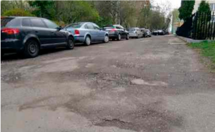
Niespełna 40-metrowy odcinek między blokiem nr 3 przy ul. Boczna Siewnej, a łukiem drogi wreszcie zostanie odnowiony
