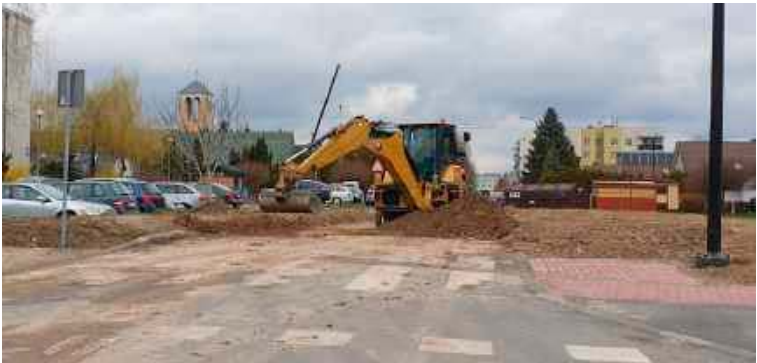
Łącznik umożliwiający wjazd z al. Solidarności w ulicę Jaworową ma być gotowy za kilka tygodni
