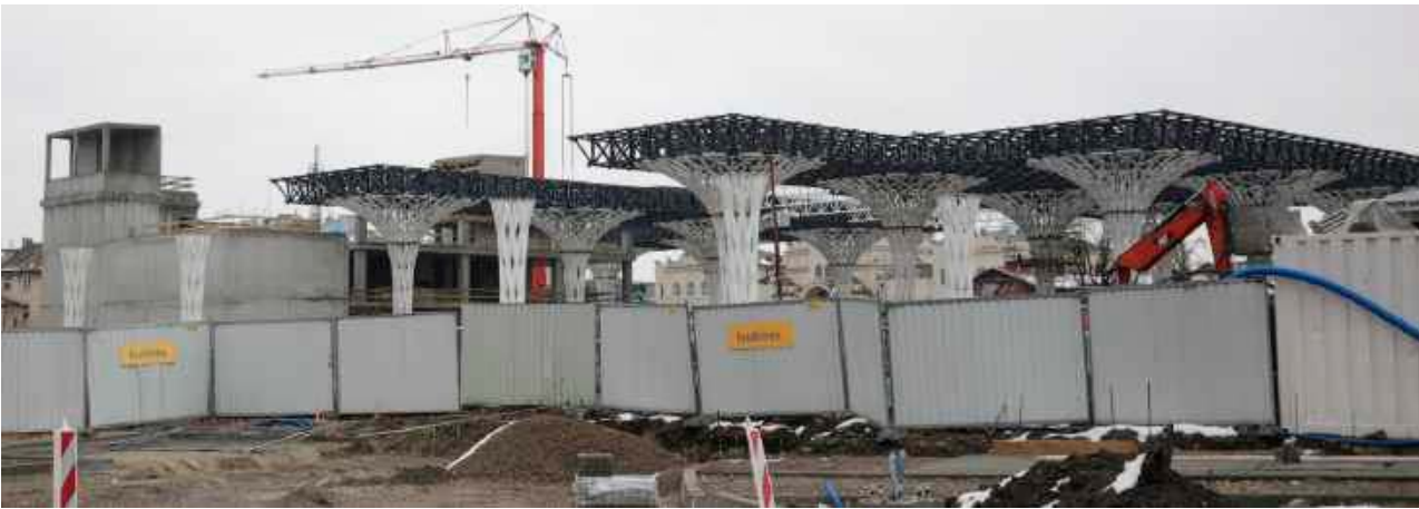
Prace przy budowie samego dworca są zaawansowane zaledwie w ok. 15-procentach
