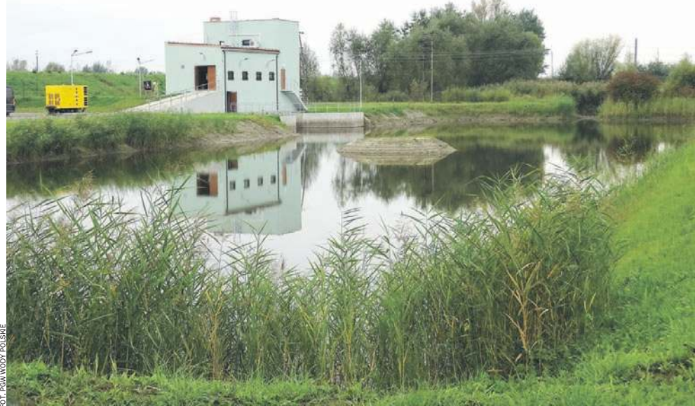
Przebudowa i rozbudowa pompowni „Nadbrzezie”
