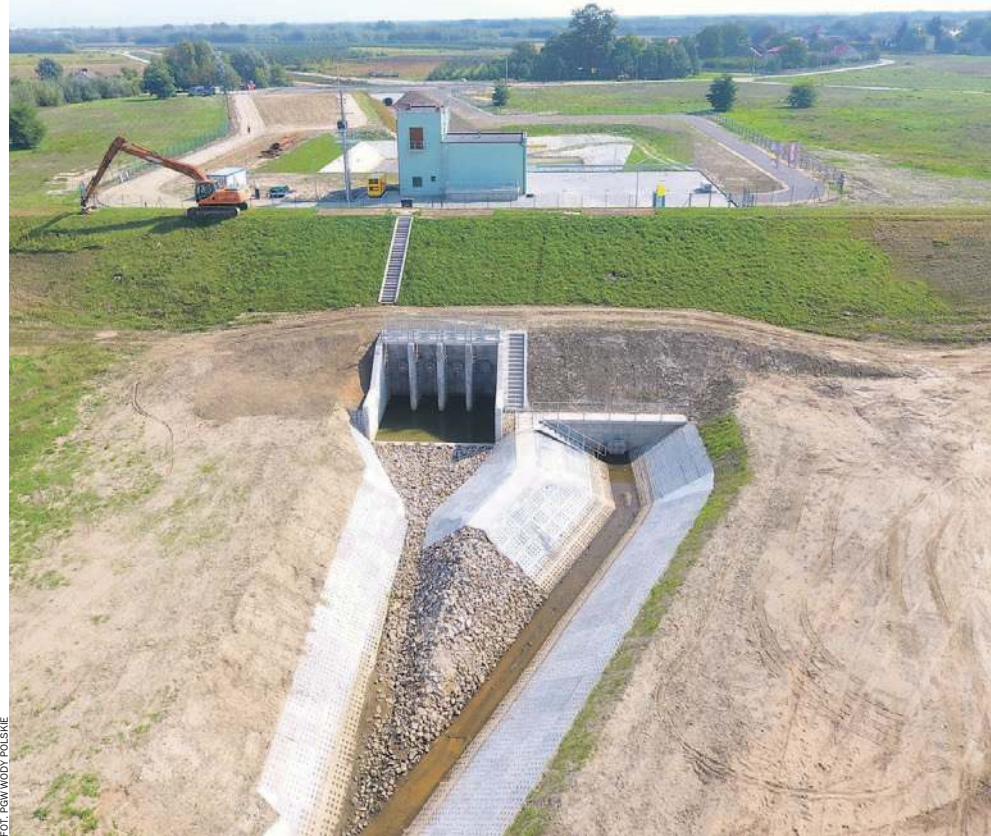
Budowa nowej pompowni „Koćmierzów”
