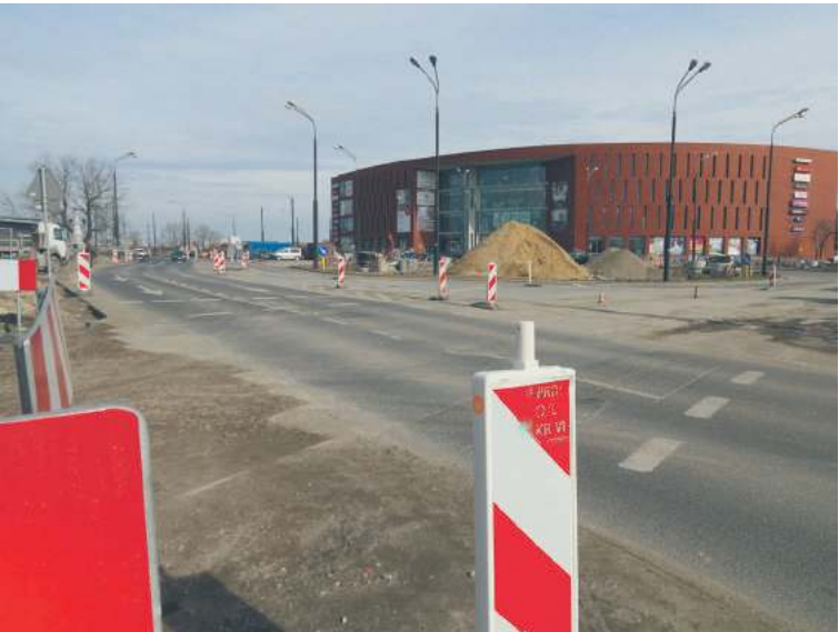
Przebudowa ronda Lubelskiego Lipca 80 sparaliżowała ruch w tej części Lublina
