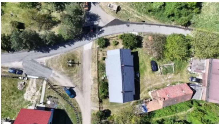
Lubiąż, remont ul. Św. Jadwigi.
