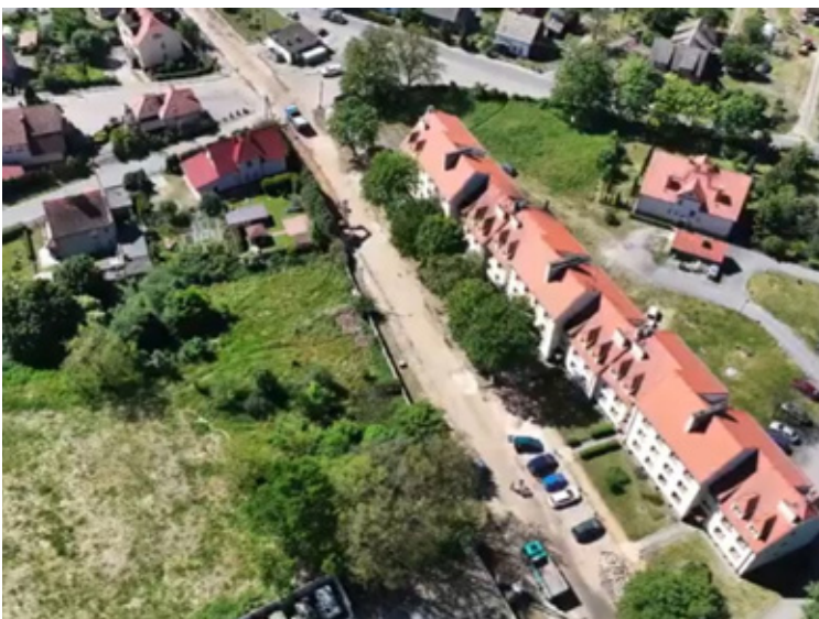
Remontowana ul. Mickiewicza.
