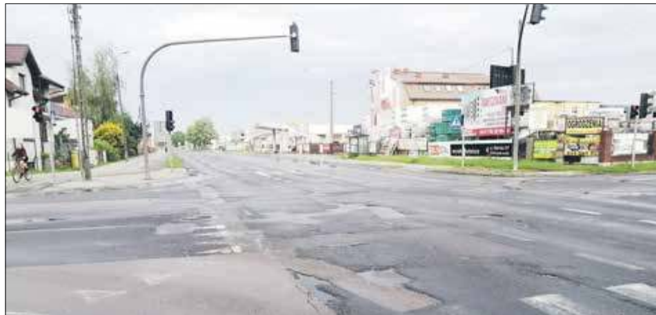
Modernizacja odcinka ul. Sidorskiej między al. Jana Pawła II a ul. Kąpielową rozpocznie się dopiero za rok
