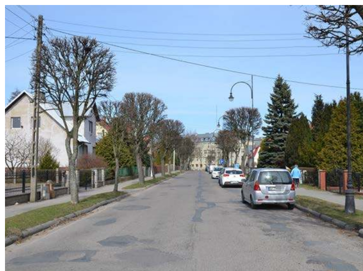
Przebudowa Wicka Rogali obejmuje część drogową i energetyczną.
