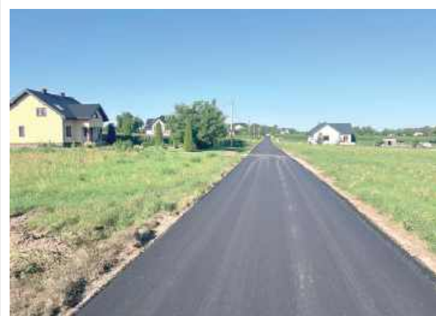
Na terenie gminy Sobolew powstają kolejne odcinki dróg
