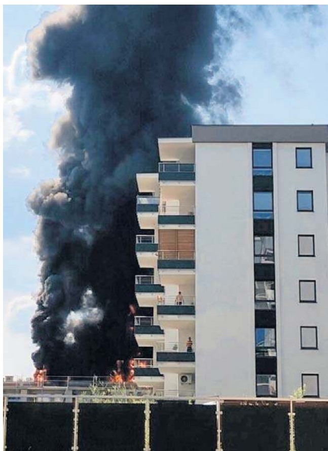
Do pożaru styropianu na dachu bloku przy ulicy Lecha w Kielcach doszło w środowe popołudnie, 1 lipca
