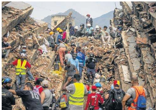
Podczas dwóch trzęsień ziemi wielopiętrowe budynki w stanie La Guaira „runęły jak kostki domina”
