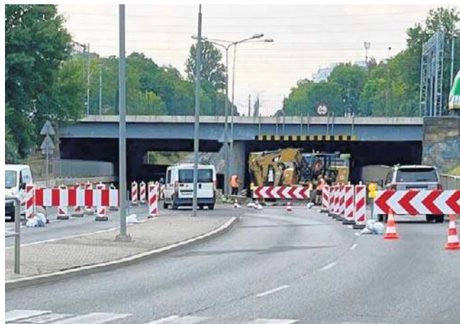
Zamknięty odcinek jezdni pod wiaduktem przy Alei Grzecznarowskiego.
