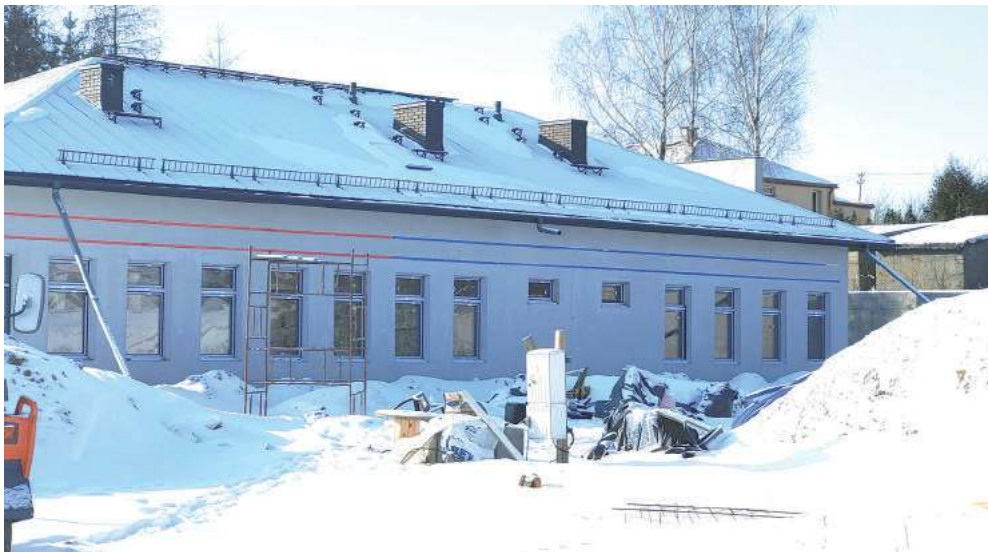
W budynkach robotnicy wykonują instalacje i kładą płytki
