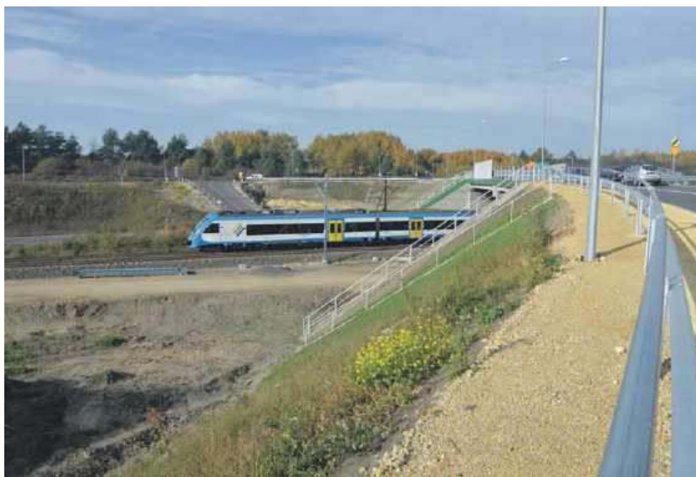
Jaworzno - nowy wiadukt zwiększył poziom bezpieczeństwa ruchu kolejowego i drogowego oraz usprawnił komunikację
