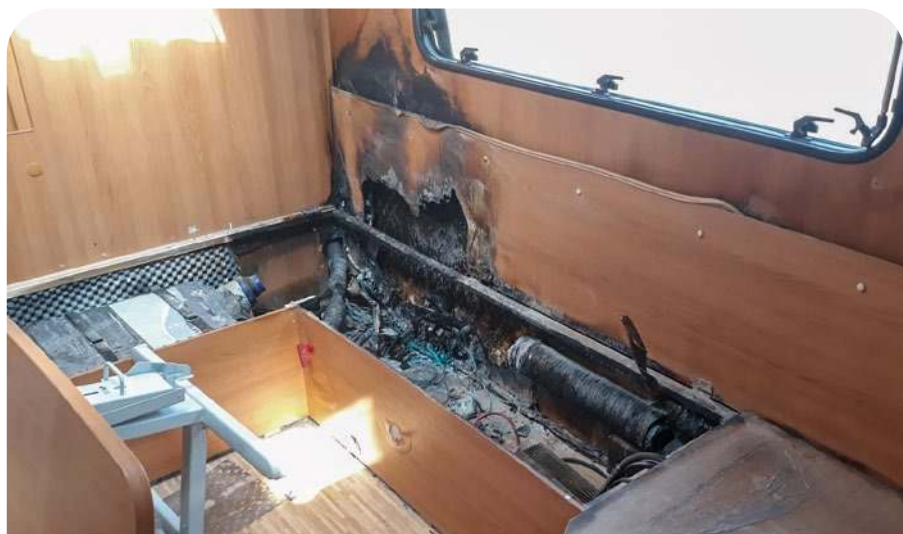
Czasem niewielka usterka może się przerodzić w poważne zdarzenie. Na szczęście tutaj udało się poskromić ogień i przyczepa została naprawiona
