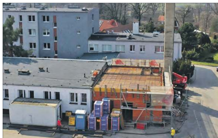
Trwa przebudowa niefunkcjonalnej kotłowni w Prudniku na archiwum spełniające wysrubowane normy architektoniczne. Inwestycja o wartości 1,7 mln zł obejmuje nadbudowę piętra oraz gruntowną modernizację wnętrza, instalacji i elewacji.
